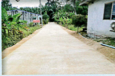
2.โครงการก่อสร้างถนน คสล. สายสวนพริกพัฒนา 1/5 หมู่ที่ 1 บ้านสวนพริก
