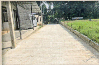
5.โครงการก่อสร้างถนน คสล. สายหนองกกพัฒนา 2/2 หมู่ที่ 2 บ้านหนองกก
