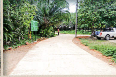
7.โครงการก่อสร้างถนน คสล. สายไสไทยพัฒนา 6/3 หมู่ที่ 4 บ้านไสไทย
