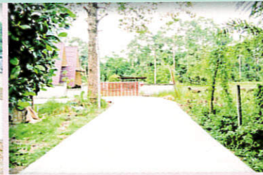
14.โครงการก่อสร้างถนน คสล. สายแหลมโพธิ์พัฒนา 1/9 หมู่ที่ 6 บ้านแหลมโพธิ์
