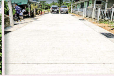
15.โครงการก่อสร้างถนน คสล. สายคลองหินพัฒนา 1/11หมู่ที่ 7 บ้านคลองหิน
