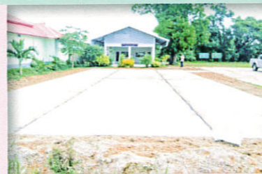
13.โครงการก่อสร้างลานคอนกรีต หน้าอาคารชมรมผู้สูงอายุตำบลไสไทย หมู่ที่ 5 บ้านอ่าวน้ำเมา
