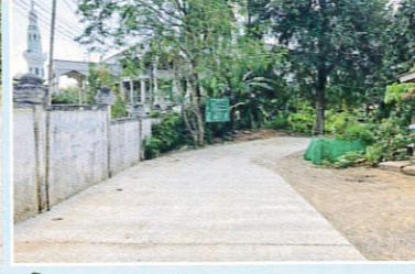
4.โครงการก่อสร้างถนน คสล. สายหนองกกพัฒนา 4/1 หมู่ที่ 2 บ้านหนองกก
