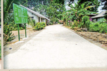
8.โครงการก่อสร้างถนน คสล. สายไสไทยพัฒนา 2/4 หมู่ที่ 4 บ้านไสไทย
