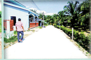
12.โครงการก่อสร้างถนน คสล. สายอ่าวน้ำเมาพัฒนา 4/4 หมู่ที่ 5 บ้านอ่าวน้ำเมา
