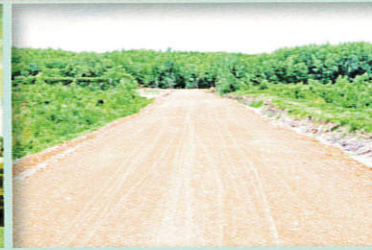
11.โครงการบุกเบิกก่อสร้างถนน สายอ่าวน้ำเมาพัฒนา 8/1 หมู่ที่ 5 บ้านอ่าวน้ำเมา
