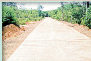
9.โครงการก่อสร้างถนน คสล. สายไสไทยพัฒนา 15 หมู่ที่ 4 บ้านไสไทย
