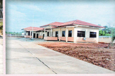
16.โครงการก่อสร้าง ศพต.บ้านคลองหิน หมู่ที่ 7 บ้านคลองหิน
